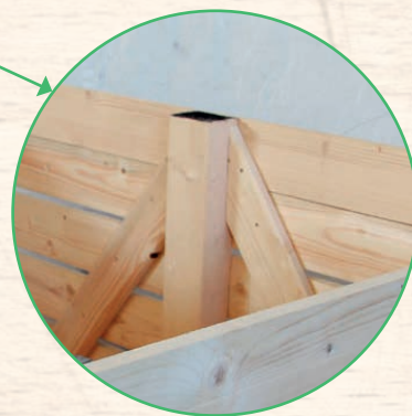
Innenraumdetail - zentrales Prisma
